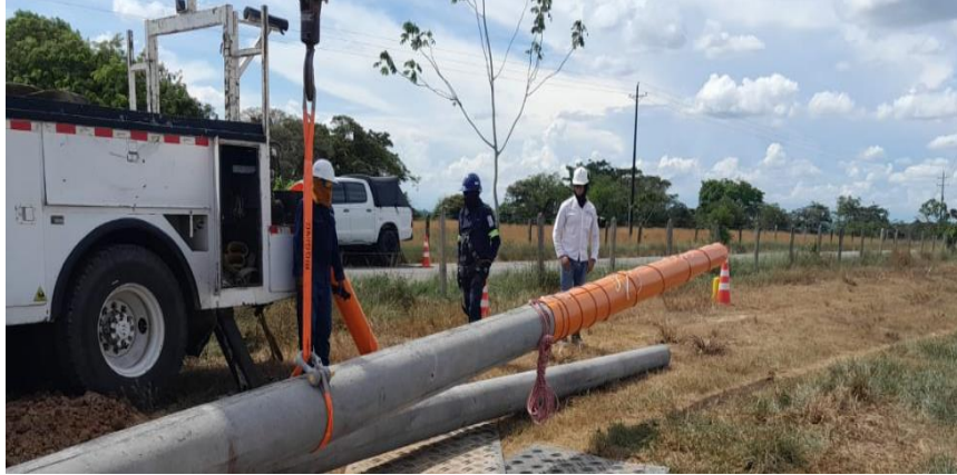
Figura 6. Izajes de posteria de concreto
